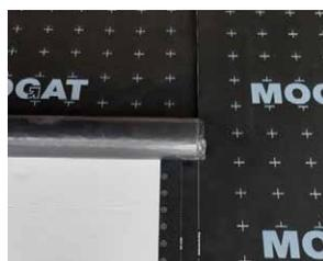
Im verklebten Aufbau (Anlegehilfe verklebt) wird die nächste Bahn mit einer Überlappung, von mindestens 8 cm an Nähten und mindestens 10 cm an Stößen und Anschlüssen, ausgerollt und ausgerichtet und wieder zur Hälfte auf einen Wickelkern aufgerollt. Die Ablösefolie wird eingeschnitten, beim Ausrollen abgezogen und die Bahn an den Untergrund angedrückt. Mit der anderen Hälfte wird in gleicher Weise verfahren. Die Naht wird „kalt“ verklebt. (KSK-Bitumen auf Abflämmfolie)
