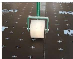
Die Nähte und Kopfstöße werden zusätzlich mit einer Andruckrolle fixiert. Im Kopfstoßbereich wird eine thermische Aktivierung empfohlen.
