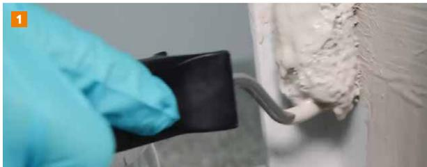
Nach Auftragen der Grundierung und Ansetzen von MOGAT LIQUID DA wird das Material vorgetragen.
