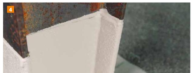
Nach Auftragen der Deckschicht wird das Kleband entfernt, eine optische Anpassung ist anschließend möglich.
