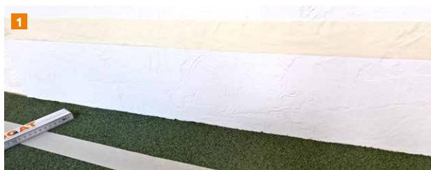
1 Lose Bestandteile und Verunreinigungen entfernen, Reinigen und Abkleben der Arbeitsfläche
