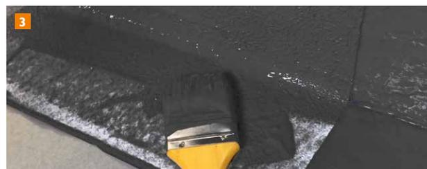
3 MOGAT LIQUID SOLO Vlies in die frische Einbettschicht einlegen, blasenfrei einarbeiten und ohne Warten das Vlies mit einer weiteren Schicht (Deckschicht) versehen.
