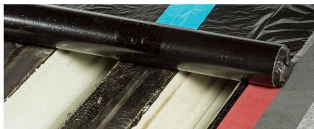
Verlegung der MOGAFIX KSK-D Uni auf Trapezblech: Zur vollflächigen Verklebung, Entfernung der unterseitigen Ablösefolie und der Vent-Folienstreifen. Unbeschichtete Trapezbleche müssen vorbehandelt, beschichtete können vorbehandelt werden.
