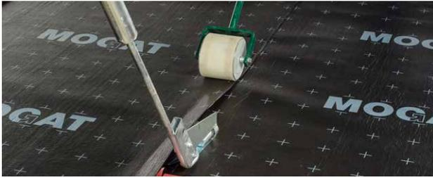
Verlegung der MOGAFIX KSK-U 35 auf MOGADÄMM (EPS): Zur vollflächigen Verklebung, Entfernung der unterseitigen Ablösefolie und der Vent-Folienstreifen.
