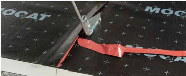
Verlegung der MOGAFIX KSK-U Uni: Bei thermischer Aktivierung der Naht wird gleichzeitig der rote Nahtstreifen entfernt.
