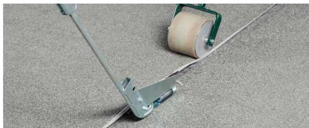
Aktivierung des Thermrands mittels Nahtbrenner.
