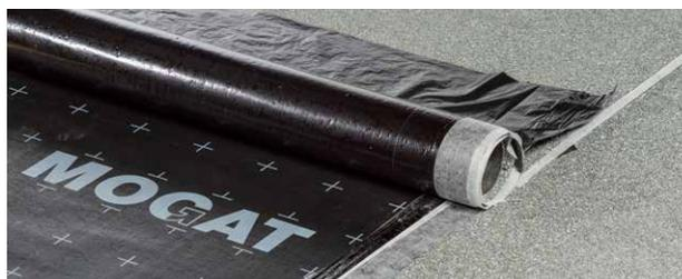
Entfernung der Ablösefolie zur flächigen Verklebung.
