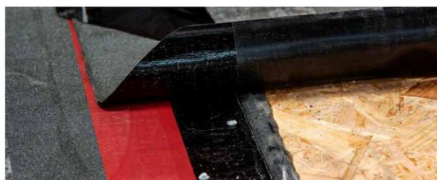
Verlegung der MOGAFIX KSK-D Uni auf Holzschalung: Ablösefolie verbleibt als Trennlage. Die Naht wird erst genagelt und nach Ablösung des Randstreifen verklebt.
