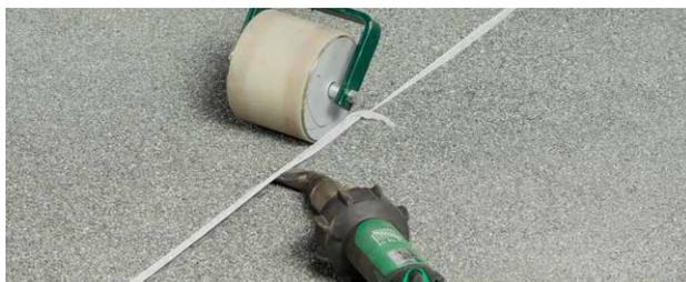
Aktivierung des Thermrands mittels Heißluftgerät.
